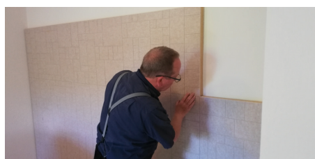
Feinjustierung: Ecken genau ausrichten
