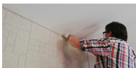
Feinjustierung: Ecken genau ausrichten
