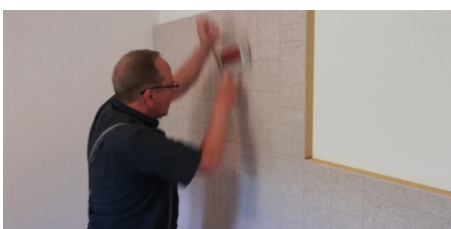
Andrücken, Anpressen mit z.B. einer Rolle
